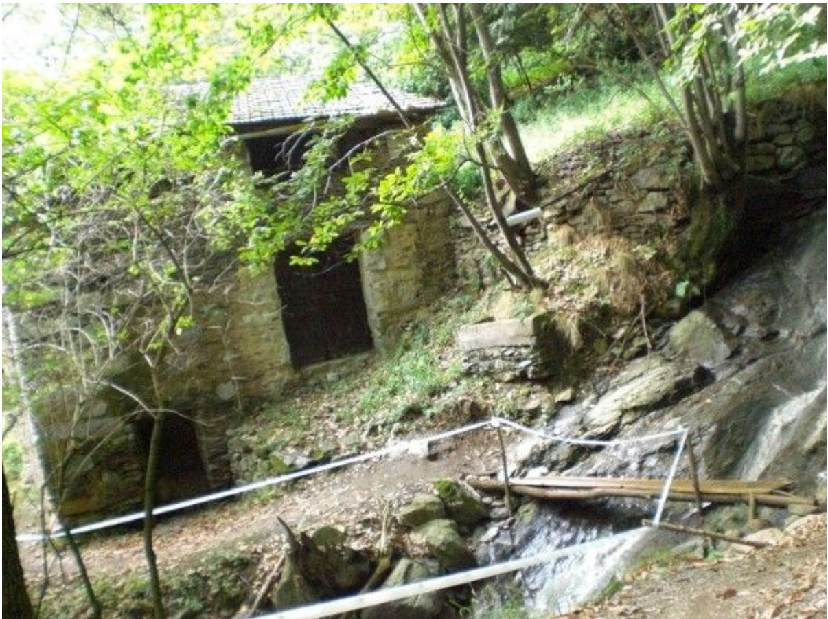
Passerella di attraversamento di un rio lungo il percorso
